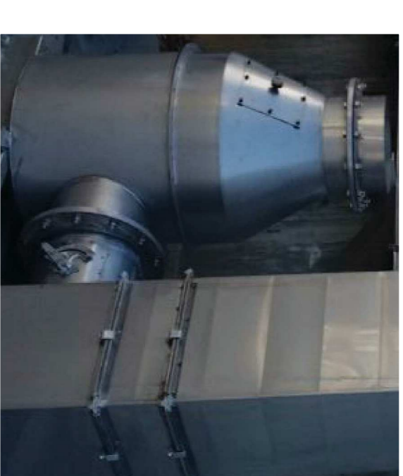
N. 1 unità di immissione aria - per ricambio parti a 1 volumetora Valvole speciali "a partito" per regolazione flusso in uscita
