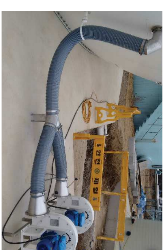
N. 1 unità di immissione aria - per ricambio parti a 1 volumetora Valvole speciali "a partito" per regolazione flusso in uscita
